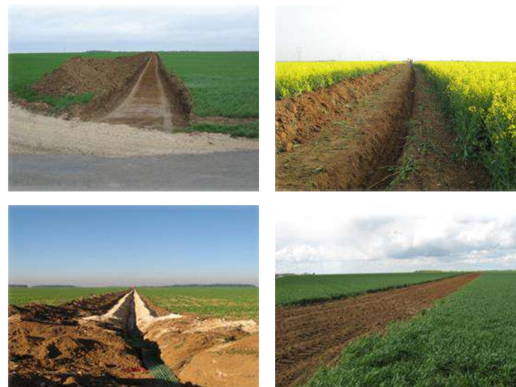
Figure 21 : RIE à la trancheuse : tranchée et mise en cordon TV, tranchée TV, enfouissement réseaux et remise en état TV (source : VOL-V)
