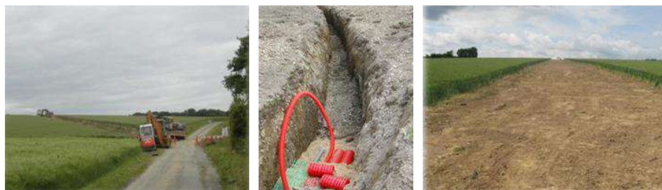
Figure 20 : RIE à la pelleuse : Travaux à la pelleuse, enfouissement des câbles et remise en état de la terre végétale (source : VOL-V)
